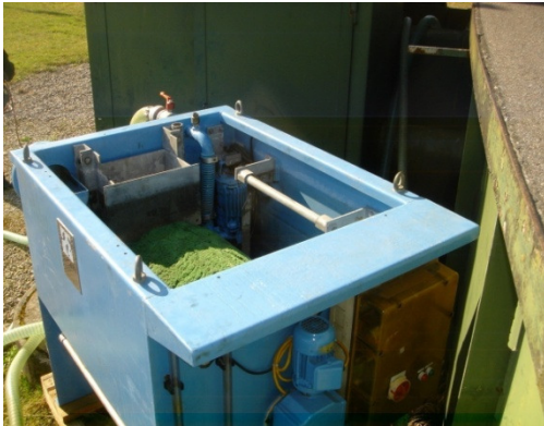
Abb. 1: Tuchtrommelfilter der Firma Mecana
