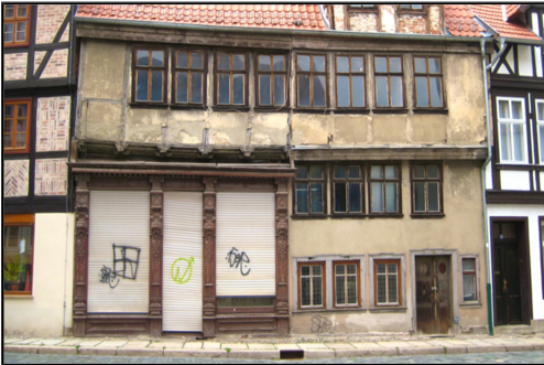
Verlassene Erdgeschosse an zentraler Lage
