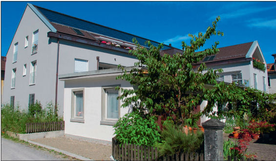
MINERGIE-A-Mehrfamilienhaus mit Büronutzung in Uster (Westansicht)
