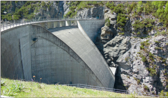
Bestehende Brücke über die Staumauer Ova Spin
