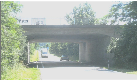
Strassenbrücke Nr. N1-220a bei Aarau Eigene Darstellung
