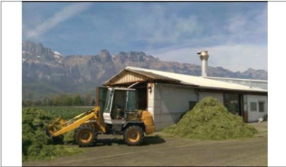
Beispiel einer Graströcknungsanlage
