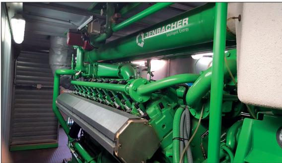
Mit Erdgas betriebenes Blockheizkraftwerk, bei welchem ebenfalls eine Simulation der Waschstufe durchgeführt wurde
