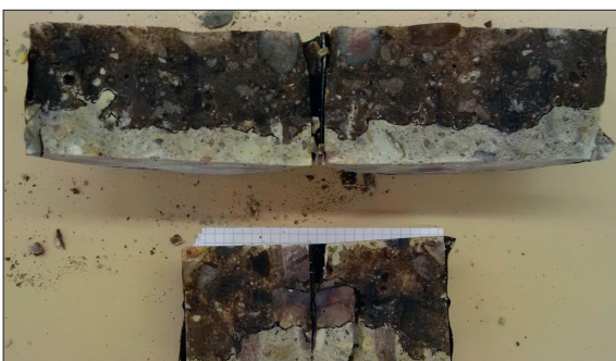
Aufgebrochene 50-mm- und 100-mm-Prüfkörper mit klar ersichtlicher Chlorideindringfront
