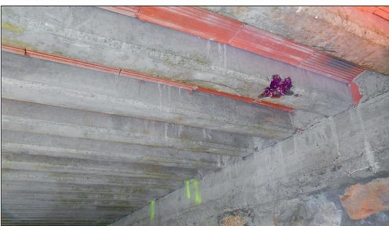
Untersicht der Brücke mit den Unterzügen, einer Sondieröffnung und den Hourdiselementen
