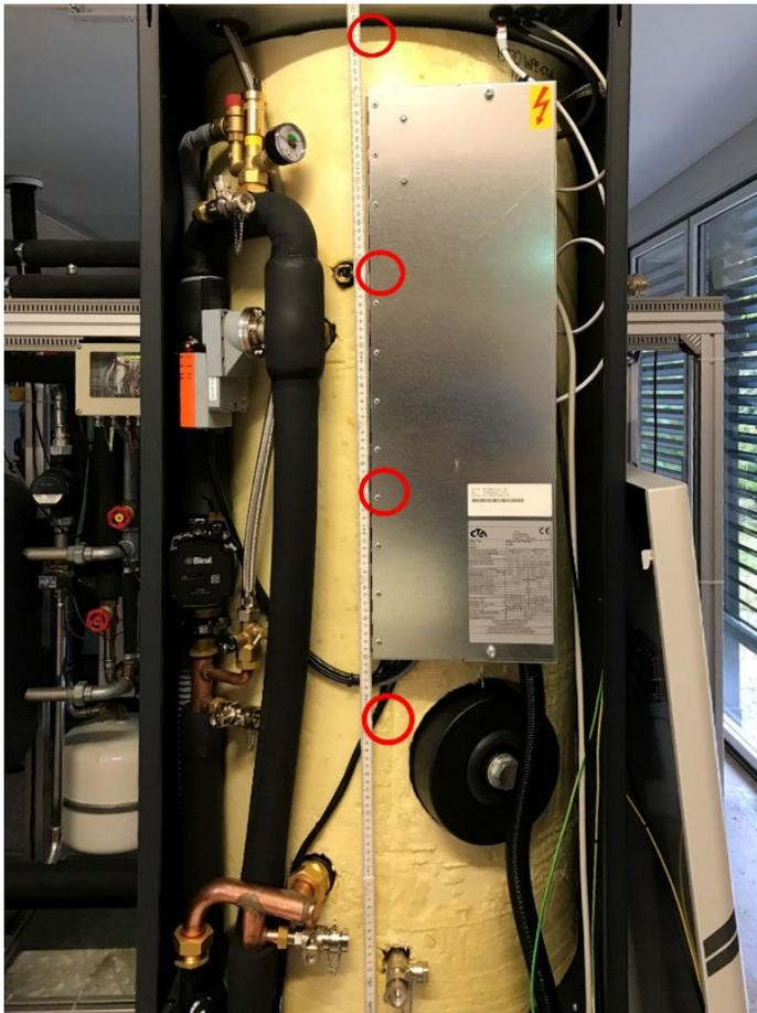
Abbildung 68: Temperaturmessstellen auf vier verschiedenen Höhen im TWW-Speicher
