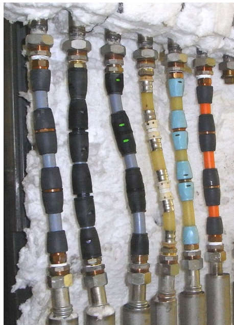
Abbildung 1: Stagnationstest mit eingebauten Rohr-Fitting-Systemen. Es wurden jeweils kurze Rohrstücke mit mehreren Muffen verbaut.
