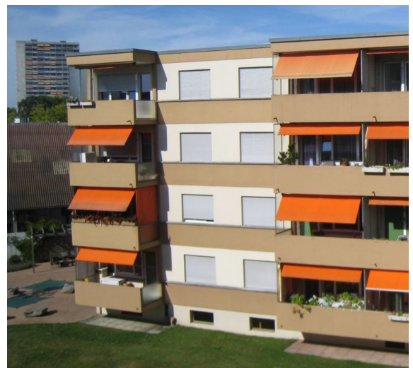
Sanierungsobjekt Mehrfamilienhaus in Bern
