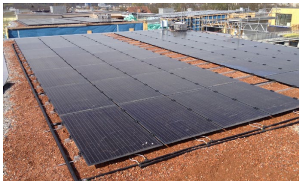
Abb. 8 fertig installiertes PVT Feld auf Dach 4
