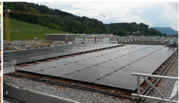
Abb. 9 fertig installiertes PVT Feld auf Dach 4
