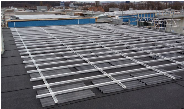
Abb. 6 installierte Unterkonstruktion K2 auf Dach 4
