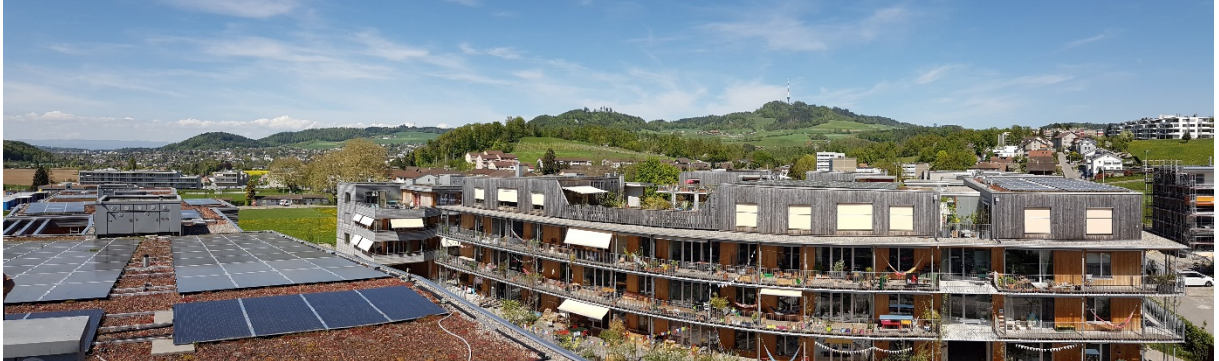
Abb. 30 Fotos April, 2018 im Vordergrund Dach Haus C im Hintergrund das Gebäude B (P&D Monitoring)
