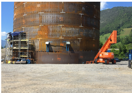
28'000 m 3 Speicher der Agro Energie Schwyz AG im Bau
