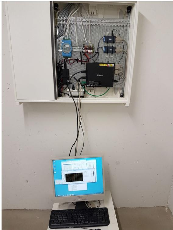
Abbildung 61: Elektroschrank mit Messrechner, installiert im Unterverteilerraum Haus A
