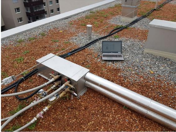
Abbildung 63: Wärmemengen –Messstellen der Solaranlage P&D Teil
