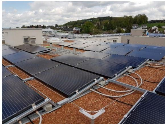
Abbildung 12: Vorne PVT-Kollektoren auf dem Dach von Haus B, die drei hintersten Reihen sind unabgedeckte, spektral selektive thermische Kollektoren der P&D-Anlage.
