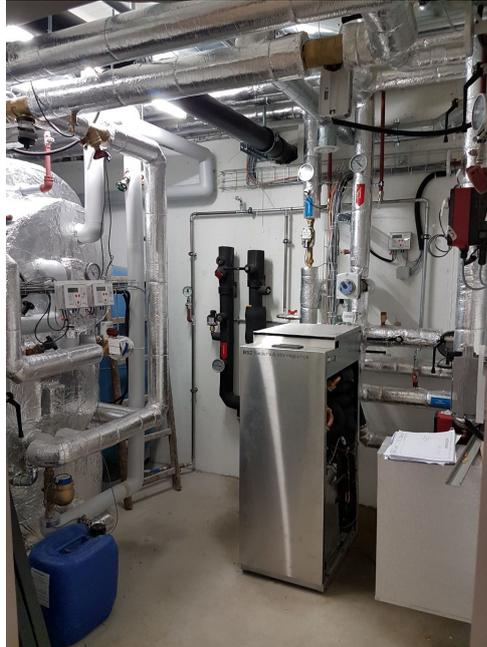
Abbildung 21: Technikraum mit Niederhub-Wärmepumpe.
