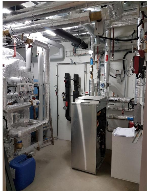
Abbildung 62: Technikraum Haus A der P&D Anlage, links der kubische Speicher, Mitte Niederhub WP, rechts isolierter Wärmetauscher der Solaranlage
