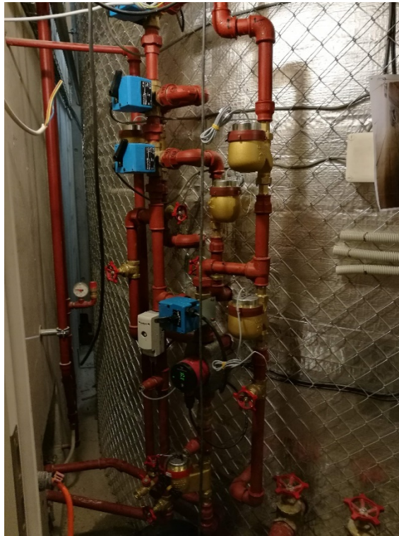
Abbildung 6: Links: Wärmehähler und Volumenstrommessgeräte im Heizkreislauf. Rechts: installiertes Pyranometer auf dem Dach.
