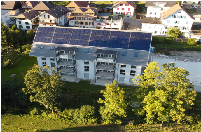
Das 2020 erbaute Mehrfamilienhaus in Huttwil ist mit 160 m 2 Solar Kollektoren belegt. Diese liefern genug Heizwärme und Warmwasser zur ganzjährigen Versorgung der acht Wohnungen. Foto: Jenni Energietechnik AG
