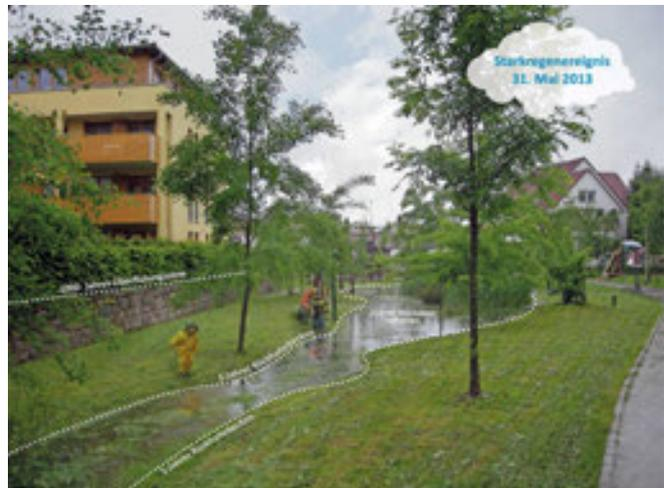
Abb.6 Aue: Ableitung, Rückhaltung und Reinigung des Regenwassers
