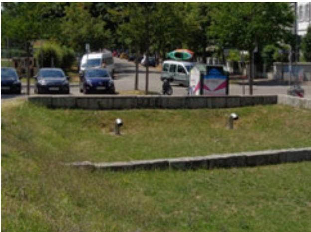
Abb. 78a+b: Drosselung mit Überlaufrohren, Freiburg (Quelle: ILF)
