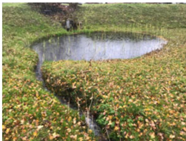
Abb. 46: Rückhaltebecken Wygarten in Wetzikon: kleine permanente Wasserfläche, im Hintergrund Überlauf mit technischem Drosselorgan (Quelle: ILF).
