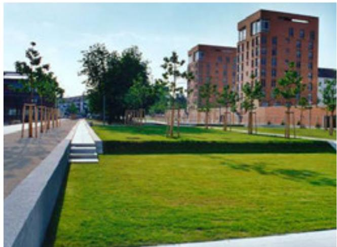
Abb.12 ...Mulden-Rigolensysteme (hier die Hainretention) weiterleiten.
