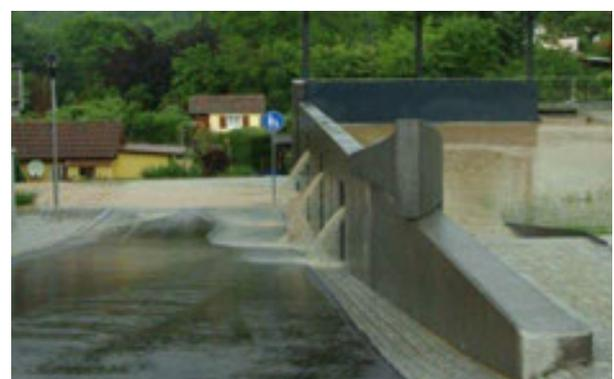
Abb. 80: Ablauf bei Starkregen aus Schlitzen in Mauer, mit eingestautem Platz (Quelle: Hauber)
