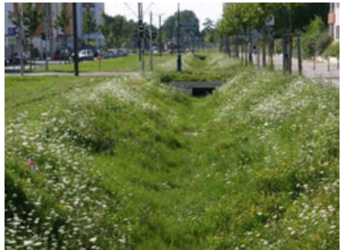
Abb.6 ...in die zwei Hauptstränge, in Form von Mulden-Rigolen.
