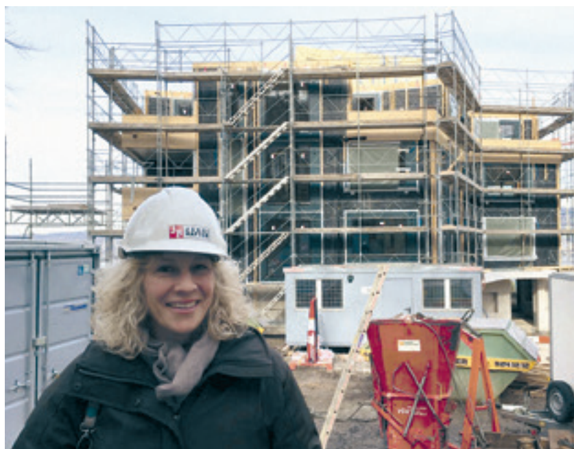
Die Siedlungs- und Wohnassistentin besichtigt die Baustelle einer neuen Siedlung
