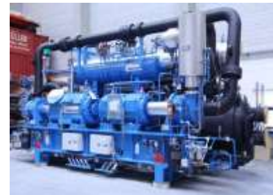
Abbildung 31: Applikationsbeispiel Abwärme Rückgewinnung aus der Marienhütte in Graz Österreich: Unitop 22/22 als 2-stufiger Betrieb mit R1234ze und bis zu 95°C mit COP von 3.51 (33.8°C/95°C) (Wojtan, 2016).
