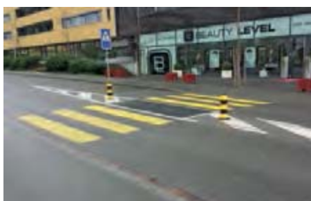
markierte Schutzinsel (Landstrasse Wettingen)
