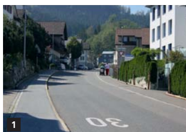
Abbildungen: Defizite in der Schul- hausstrasse
