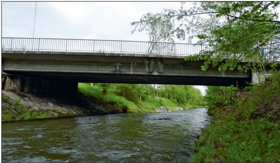
Oberwasserseitige Ansicht der vorgespannten Stahlbetonbrücke «Schachen»
