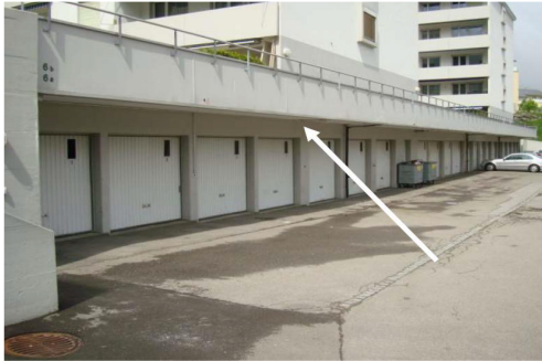
Betrachtetes Objekt: Passarelle, welche zwei Mehrfamilienhäuser erschliesst
