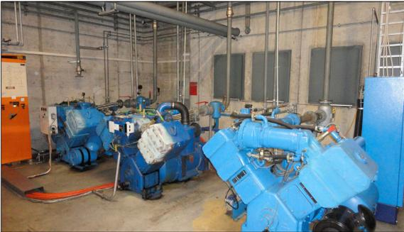
Installierte Kolbenkompressoren in der Medisize AG, welche für die Druckluftherzeugung eingesetzt werden
