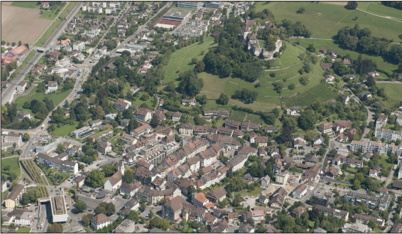
Das Schloss Lenzburg und die historische Altstadt sind Lenzburgs Wahrzeichen. Der sonst attraktive Raum wird jedoch vom angrenzenden Verkehr beeinflusst.
