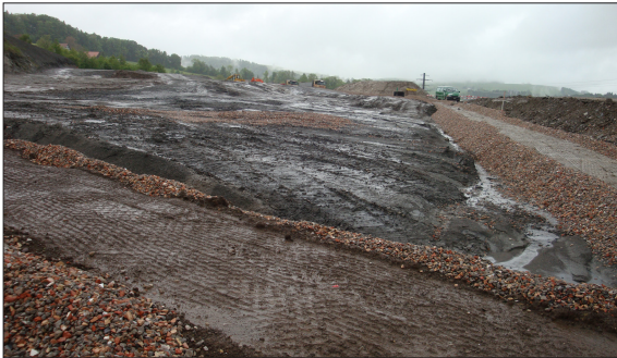
Schlackenkompartiment in der Deponie Tännlimoos (Risi AG)
