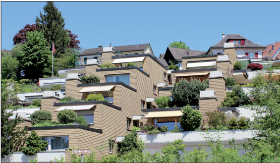
Ansicht der Liegenschaft in Männedorf mit neun Wohnungen
