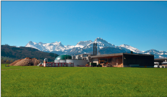
Energiezentrum Wintersried der AGRO Energie Schwyz AG in Ibach
