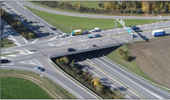
Luftaufnahme der Brücke N1-317
