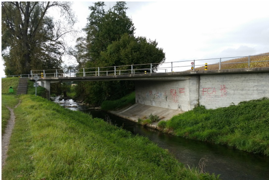
Schiefwinklige Stahlbeton-Rahmenbrücke über die Bünz, Fließrichtung links
