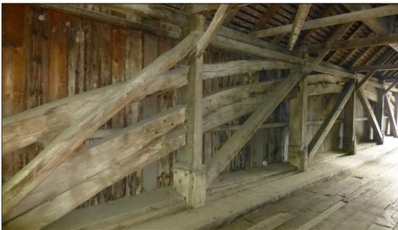
Tragkonstruktion der Brücke bei Rümlang
