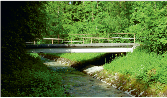
Rufibachbrücke in Schänis mit Blick Richtung Rufi
