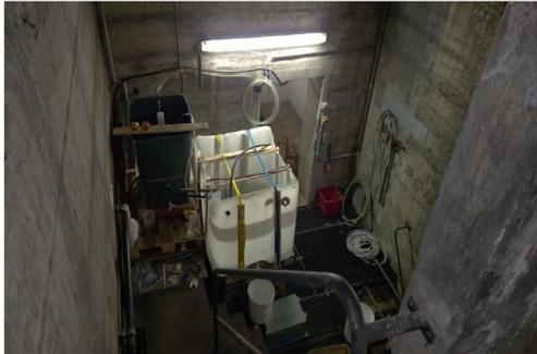
Permeattank weiss, links davon der Membrantank; die Schläuche führen durch den Durchgang rechts in eine erhöhte Kammer, wo der Feedtank ist.
