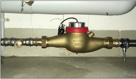
Durchflusszähler und Tauchhülse für Thermometer
