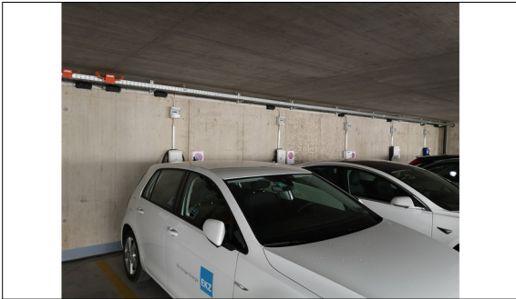
Ladestationssystem mit Elektrofahrzeugen im Parkhaus Dietikon (EKZ) Eigene Darstellung
