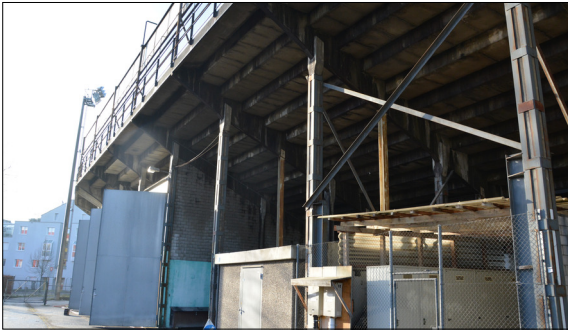
Bestehende Tragkonstruktion Rückansicht mit Garagennutzung und Trafostation EWZ Eigene Darstellung
