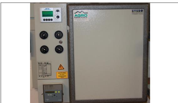
Typische Fernwärme-Übergabestation mit integriertem Wärmetauscher, Wärmehähler und der Steuerung
