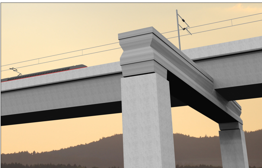
Ansicht Jochkonstruktion mit Verkleidung (Quelle: Marc Furrer)
