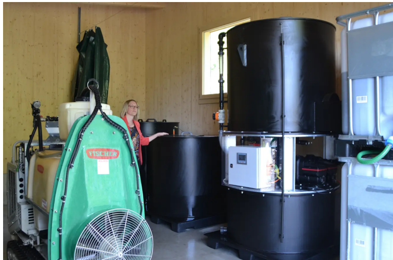
Sarah Schäfer, Projektleiterin Creabeton, erklärt die Funktionsweise des neuen Waschplatzes mit Pestizidabscheider.
