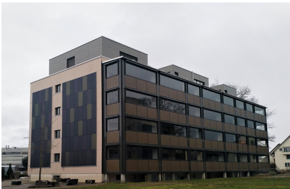
Modernisierter Zustand nach der Installation der Fassadenelemente auf die bestehende Wand mit aussenliegender Wandheizung (P&D ProsumerSkin, Bern). Fassade als auch Balkonbrüstung sind mit PV-Modulen zur Eigenstromerzeugung ausgerüstet.
