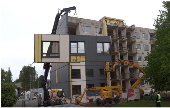
Energetische Modernisierung eines Gebäudes in Tallinn mit vorfabrizierten Elementen entwickelt im EU Projekt MORE-CONNECT.
