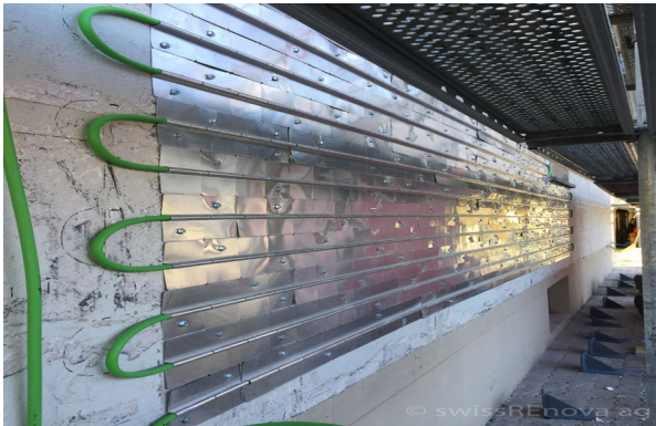
Umsetzung der aussenliegende Wandheizung in Bern (P&D Projekt ProsumerSkin). Anschliessend wurde in einem zweiten Schritt die neue vorgefertigte Fassadenelemente montiert (siehe Abbildung unten).
