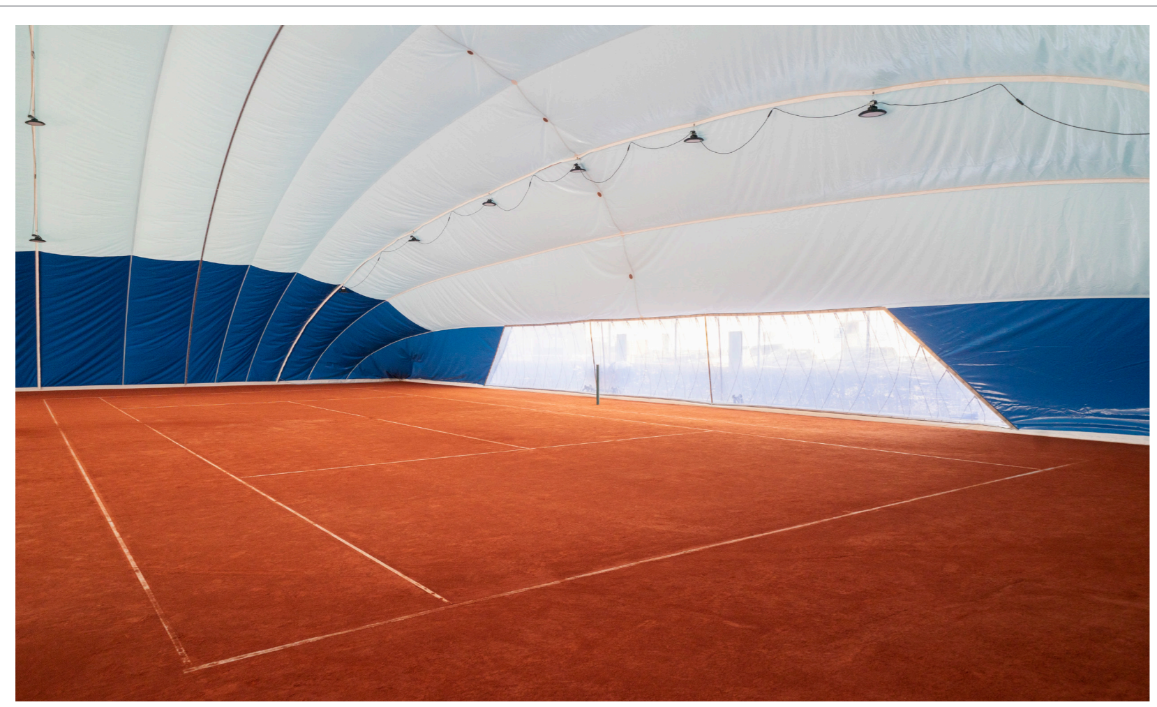
2 | Innenansicht der Halle mit Panoramaöffnung
