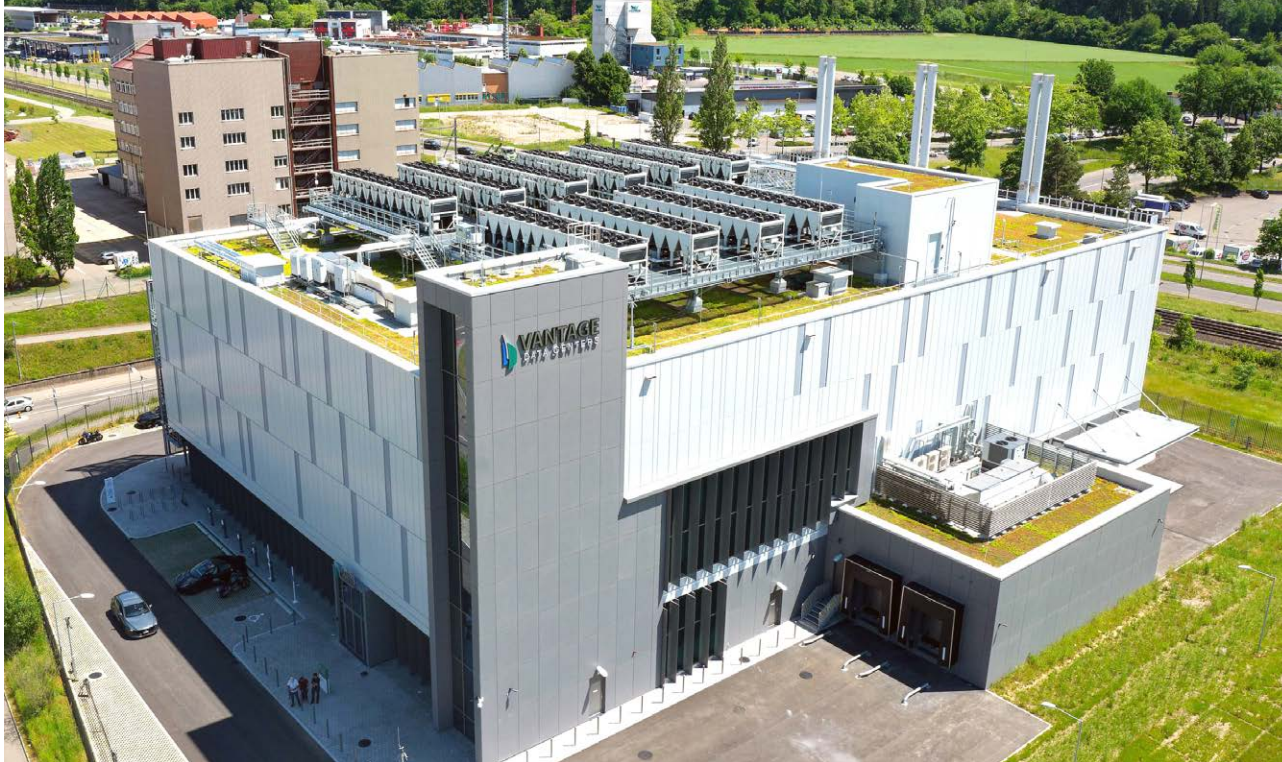
Das Vantage-Rechenzentrum in Winterthur ist einer von drei AWS-Standorten in der Schweiz. Bild: vantage-dc.com
