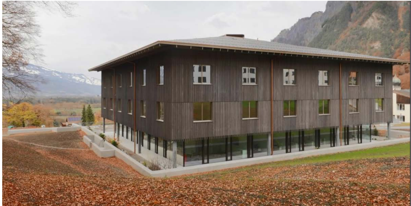
Klinik Gut, Fläsch: Mauer als Hochwasserschutz
