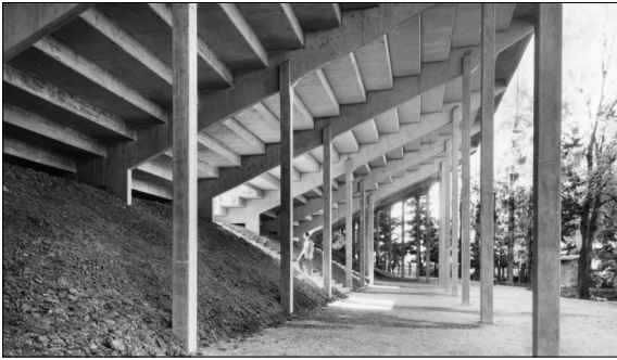
Abb. 1: Offene Rennbahn Zürich Oerlikon: Mittlere Gegentribüne, Bestand von 1953 H. Wolf-Bender; Baugeschichtliches Archiv; CC BY SA 4.0
