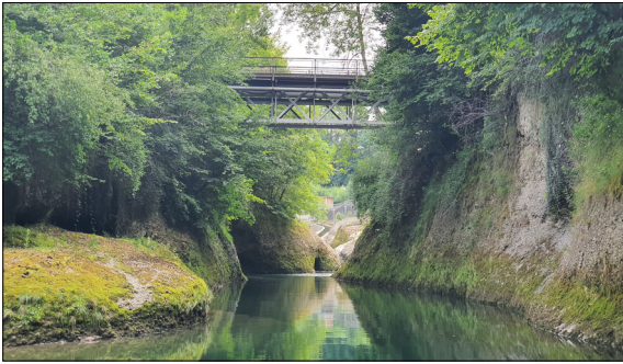
Nordansicht der Schlucht mit darüber führender 140-jähriger Stahl-Fachwerkbrücke Eigene Darstellung
