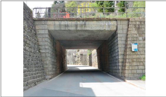
Ansicht Ost bestehender SBB-Strassenunterführung
