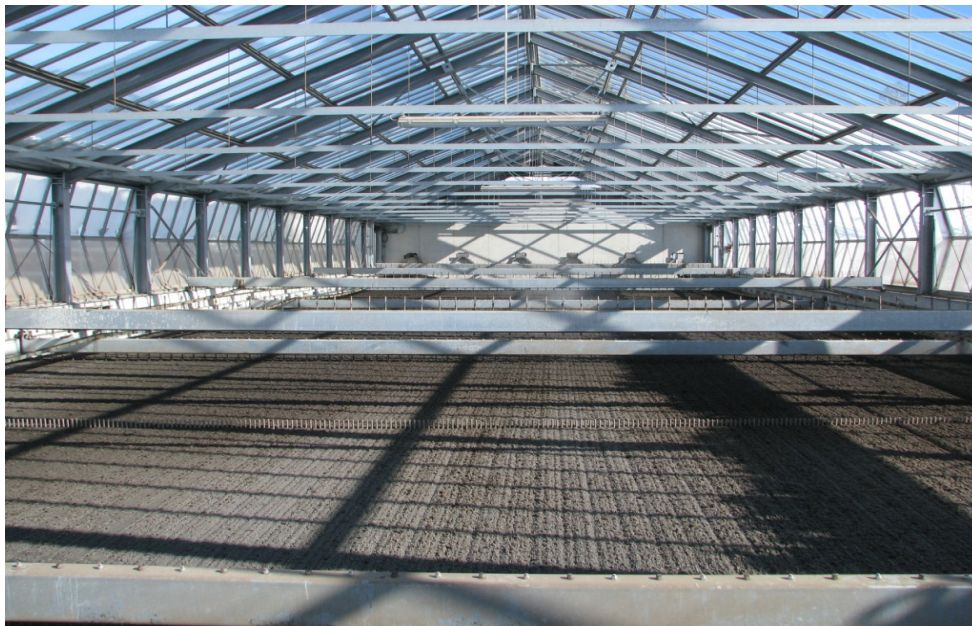
Trocknungshalle für Klärschlamm. Der anfallende Klärschlamm könnte den gesamten Schweizer Phosphor-Bedarf decken.
