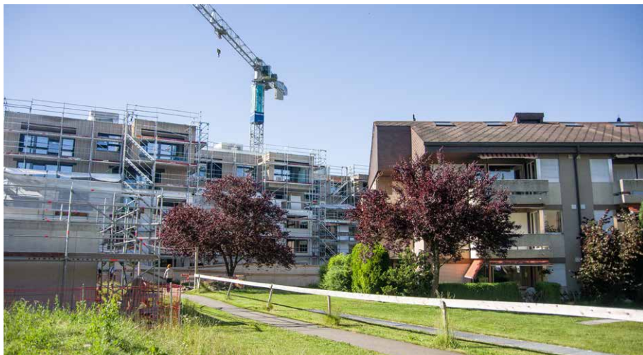
Bei grossen und peripheren Projekten ist die bauliche Etappierbarkeit zentral. Eventuell muss in einer ersten Etappe getestet werden, wie der Markt auf das Projekt anspricht. Im Bild: Etappenweise Sanierung und Aufstockung der Überbauung Nessleren in Wabern BE. Foto: M. Hunziker, VLP-ASPAN
