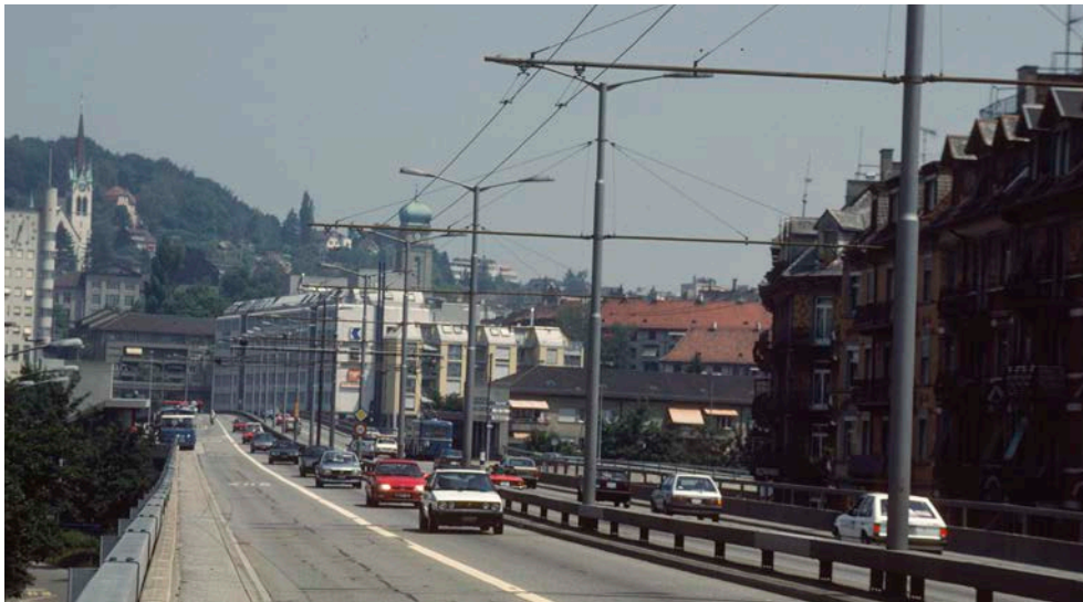
Abb. 29 Hardbrücke vor dem Umbau im Jahr 1987, Quelle: ETH-Bibliothek Zürich, Bildarchiv / Fotograf: Bärtschi, Hans-Peter / SIK_03-095632 / CC BY-SA 4.0
