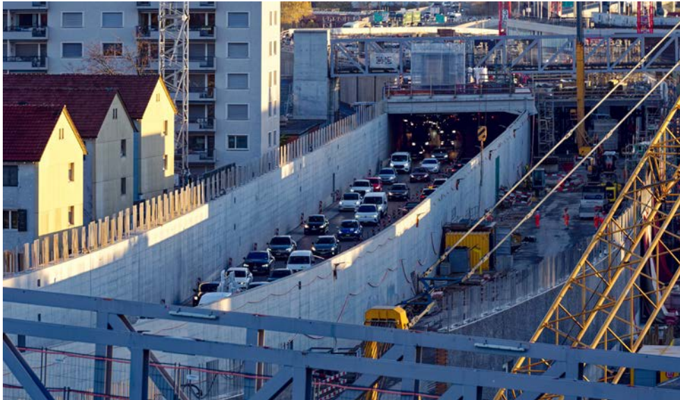
Abb. 85 Der Bau der Überdeckung Schwammengängen für den A1-Zubringer vermindert zwar die Luft- und Lärmemissionen, führt aber auch zu hohen CO 2 -Emissionen. Die Kosten und Nutzen sind gegeneinander abzuwägen, Quelle: Michael Derrer Fuchs - stock.adobe.com
