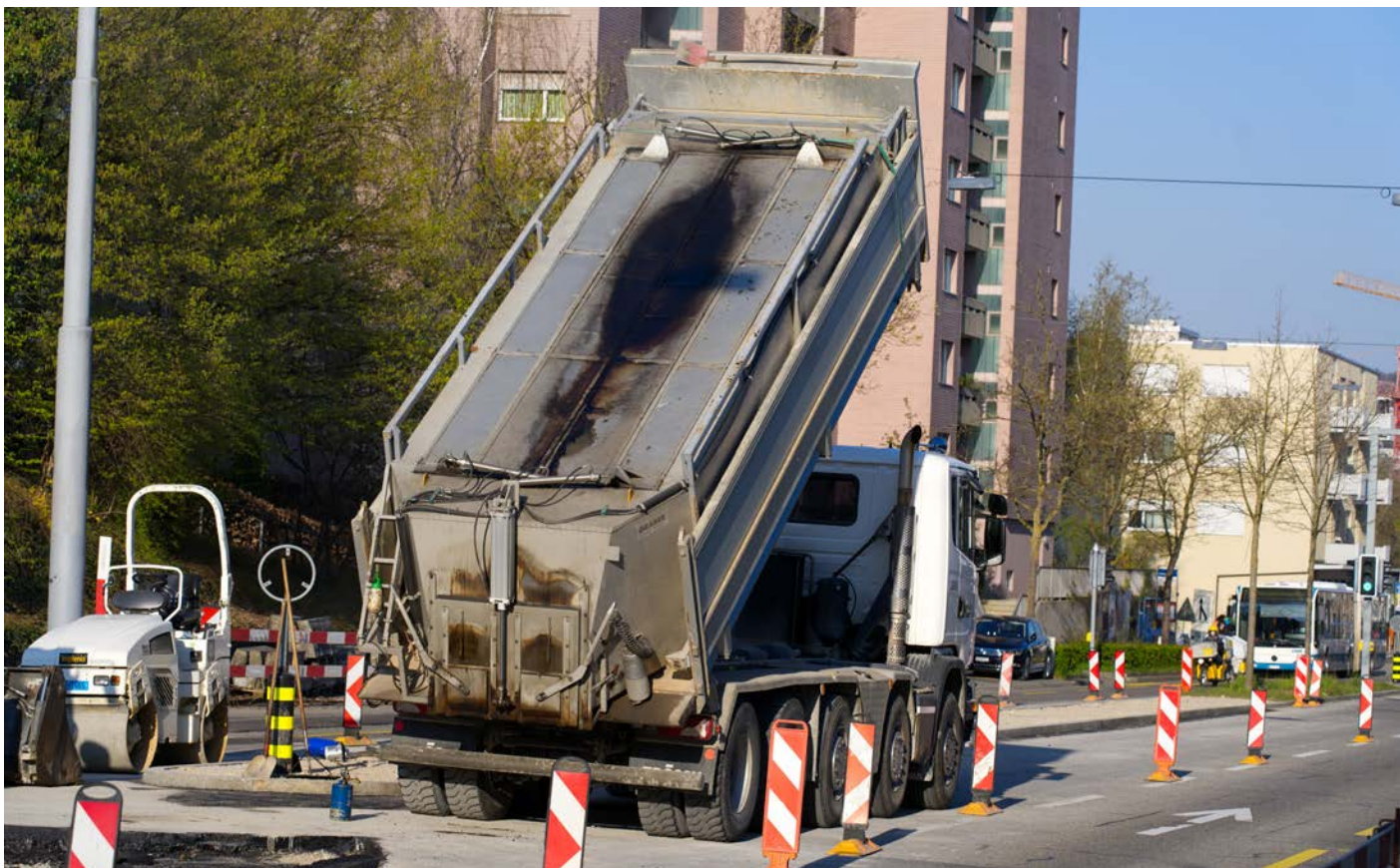
Abb. 68 Baustelle in Zürich: Im Rahmen von Baustellen sind Verkehrsversuche einfacher möglich, Quelle: Michael Derrer Fuchs - stock.adobe.com © Alle Rechte vorbehalten
