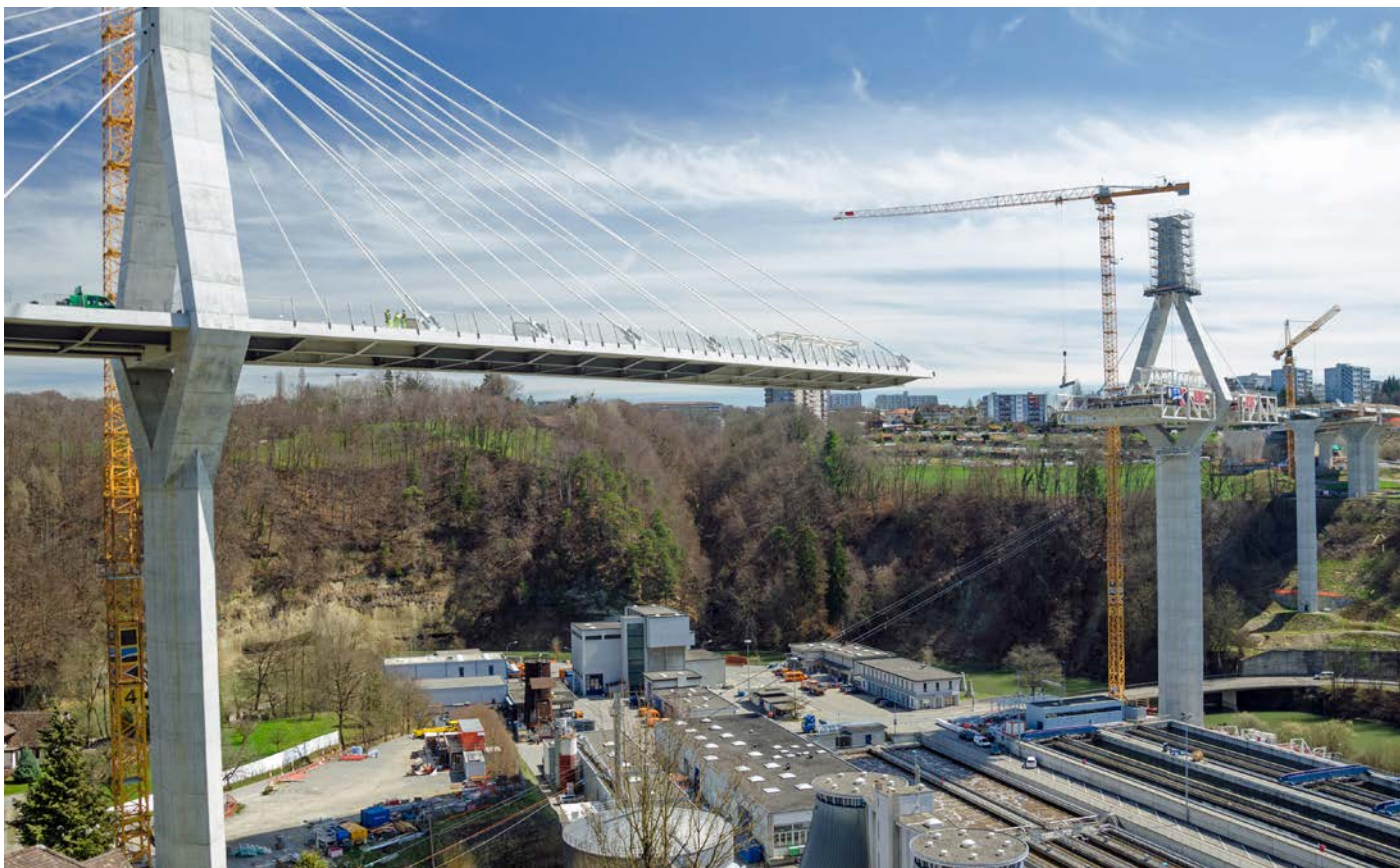
Abb. 4 Aufnahme des Baus der Poya-Brücke in Fribourg, Quelle: matheo - stock.adobe.ch © Alle Rechte vorbehalten
